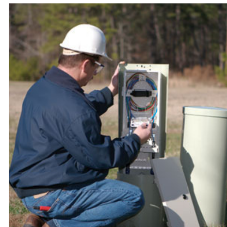
Illustrasjon: Skjøting av fiber i pidedestall
